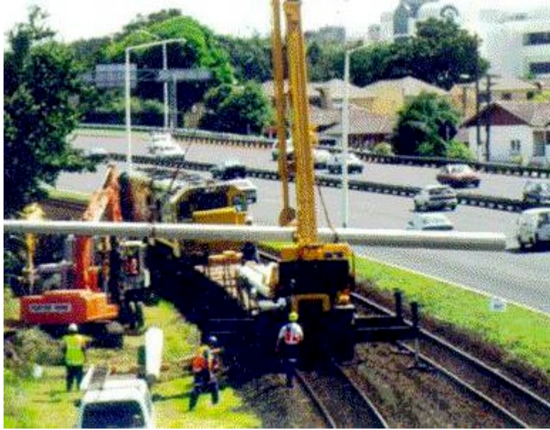
Resning av elstolpar för den tillfälliga elkraftsledningen till CBD. Källa: Mercury Energy Ltd. 1998
