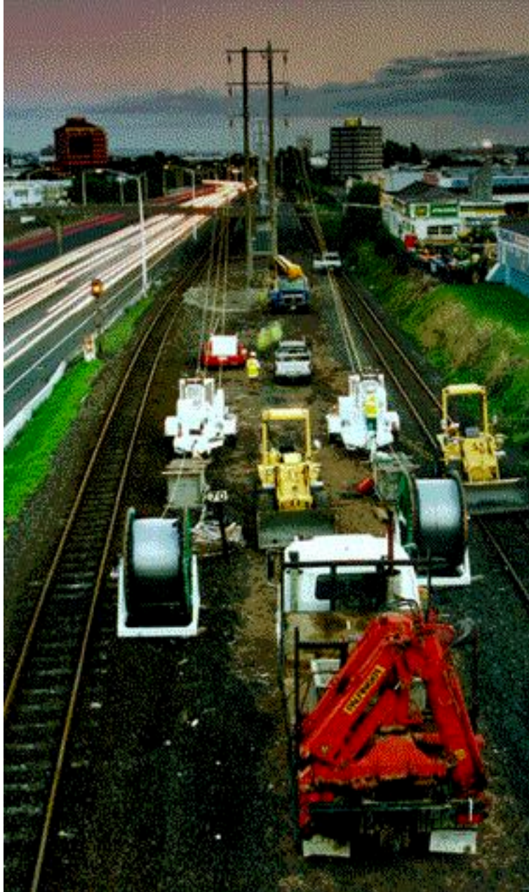
Ledningsdragning för den tillfälliga elkraftsledningen till CBD. Källa: Mercury Energy Ltd. 1998
