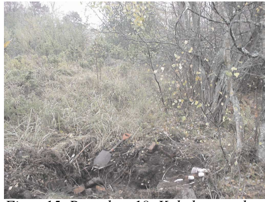
Figur 15. Provplats 18. Kabeltyp moder-nare kraftkabel av typen AKKJ.
