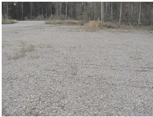
Figur 5. Miljö kring provgrop 2. Kabeltyp EKKJ.
