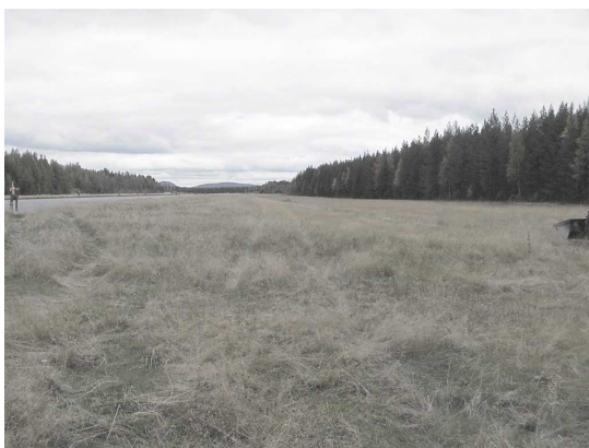
Figur 6. Miljö kring provgrop 3. Kabeltyp EKKJ. Tre kablar låg parallellt på 70 cm djup.
