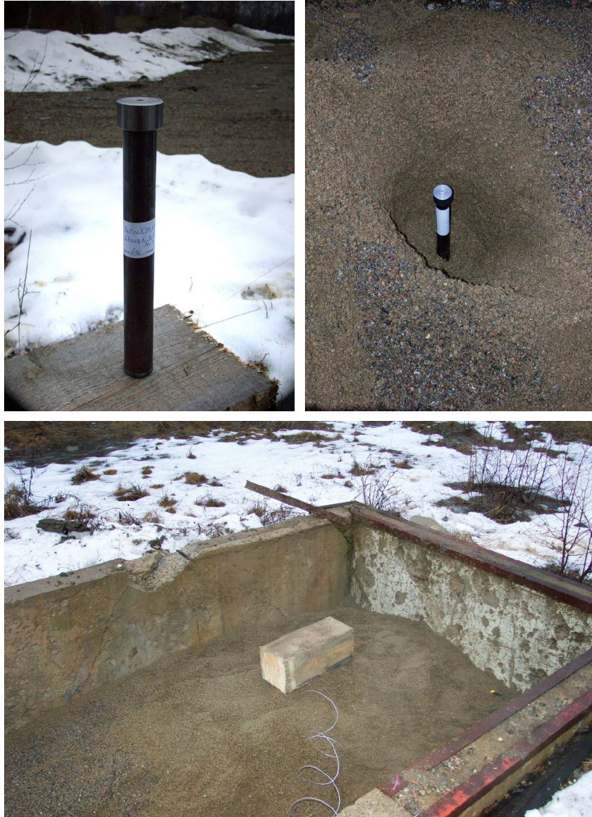
Figur 8 Försöksuppställning med stålrör DN 25.
