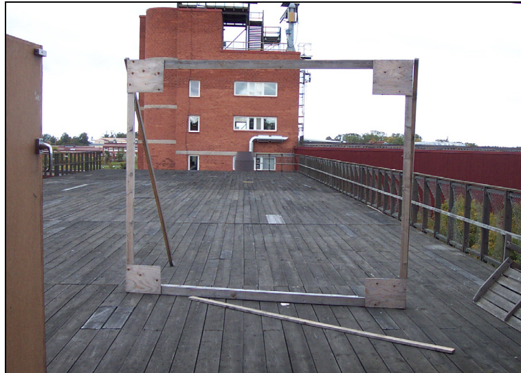
Figur 11: Mätsträcka över taket på huskropp E.
