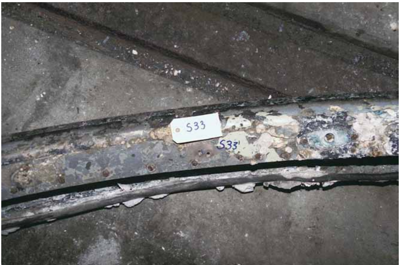
Figur 38 Detalj, splitterskada S33 i dörrkarm mellan bakre lastdörr och fallskärmsdörr
