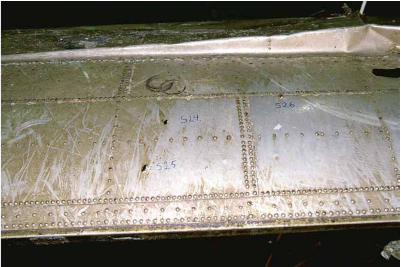
Figur 29 Utgående splitterskador S24-S26 i skrovet ovanför bakre lastdörr
