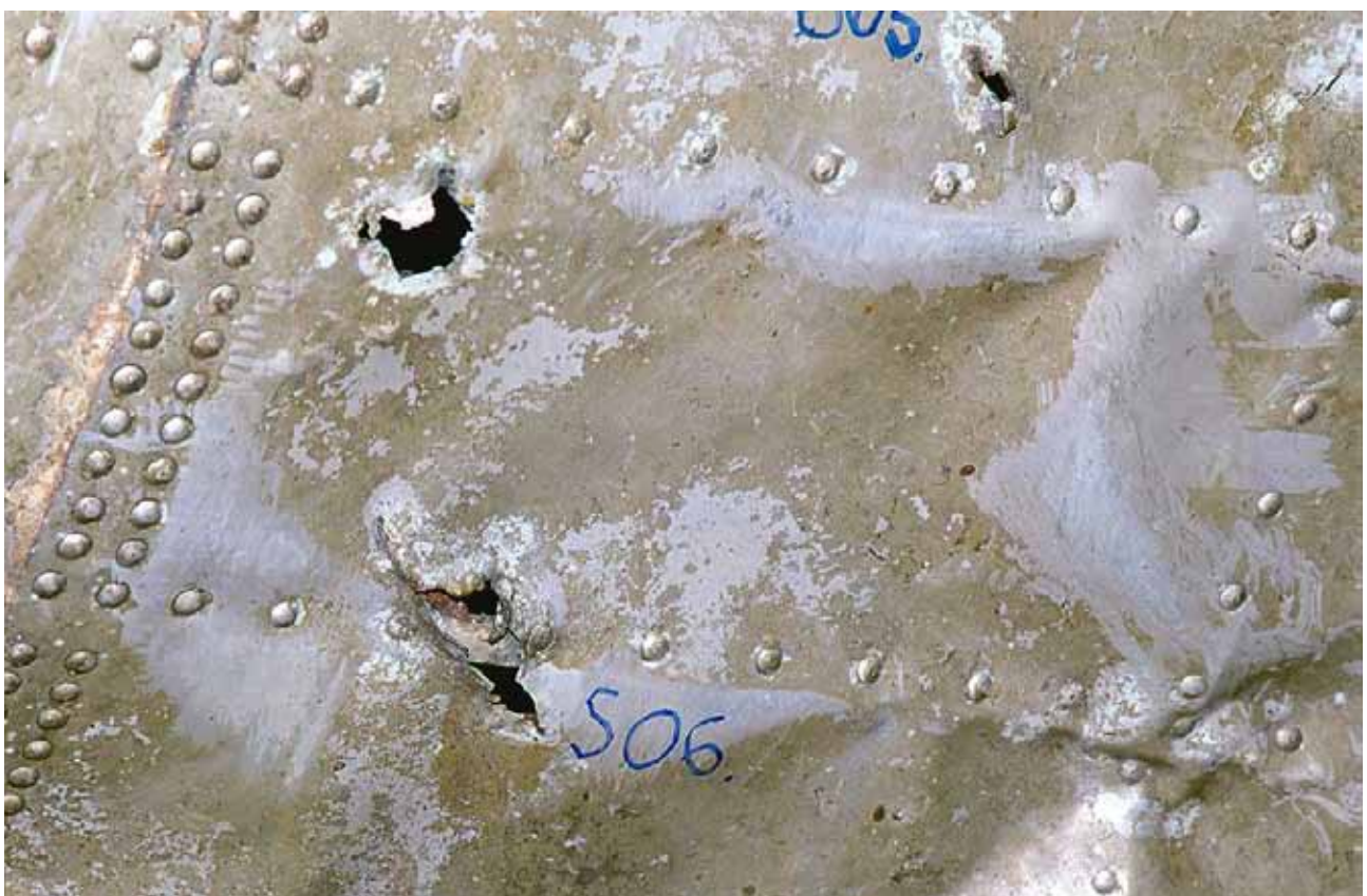
Figur 15 Detalj, utgående splitterskada S06 (S05 synlig i bildens överkant)
