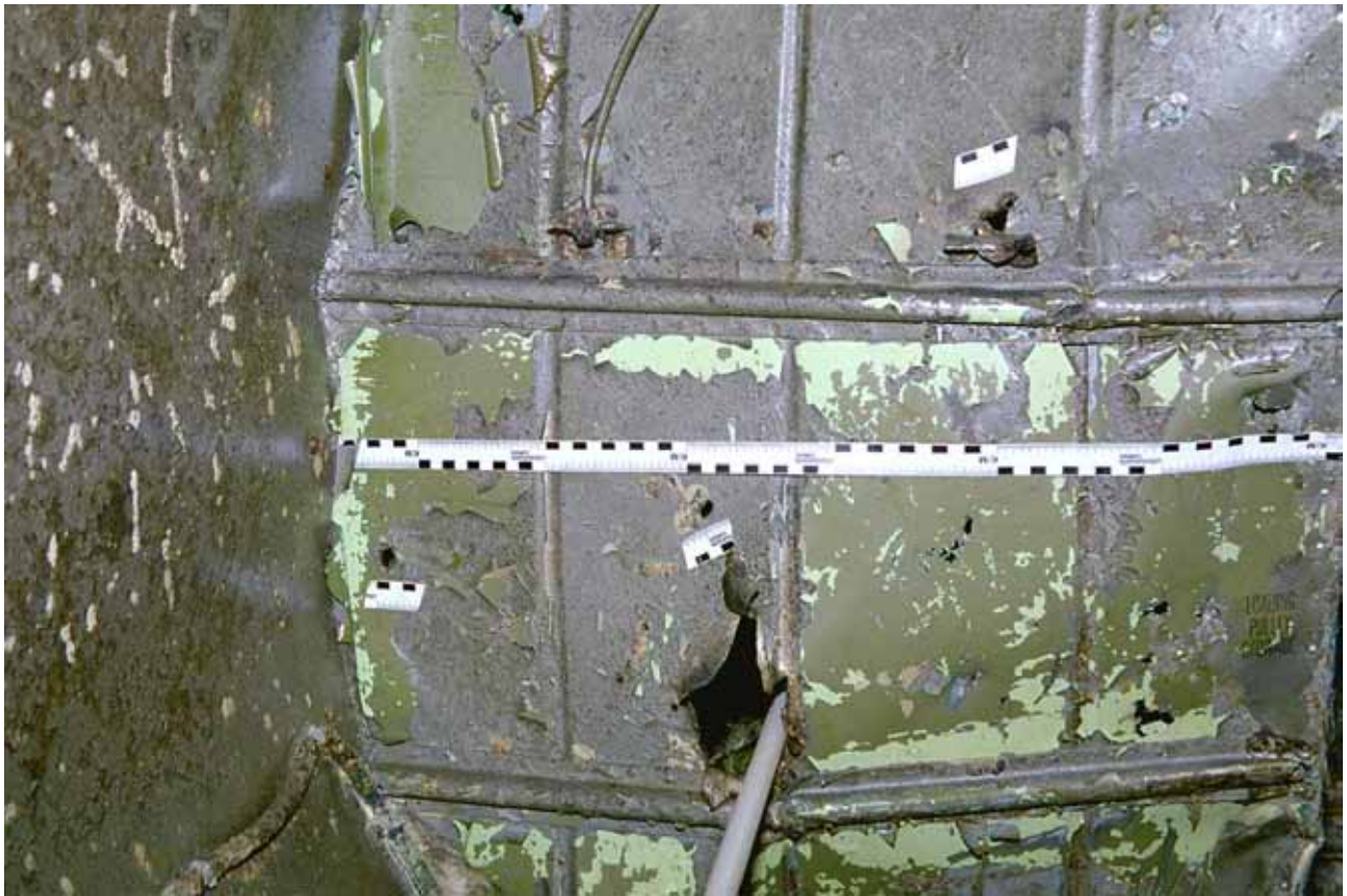
Figur 10 Inre splitterskador i främre toalettvägg, sannolikt sammanhörande med ingångsskada S02
