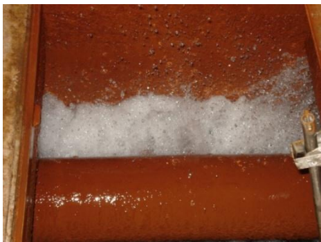
Oxidering av ingående vatten för vidare utfällning av järn och mangan respektive sandfilterbassäng vid Forslunda Vattenverk, Umeå. Foto: Elisabet Waller
